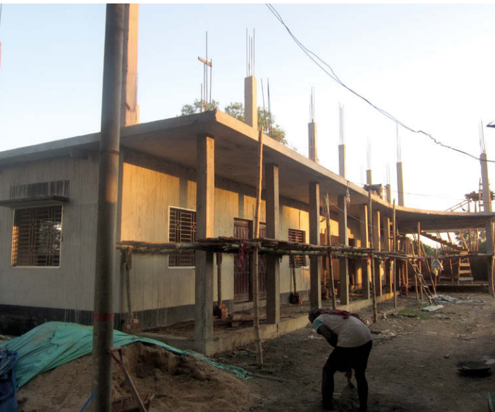
Das Erdgeschoß konnte bereits fertiggestellt werden
